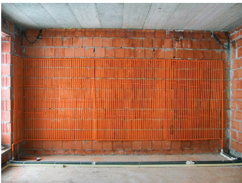
Jednotlivé díly topného systému se montují na vnitřní stranu obvodových stěn
