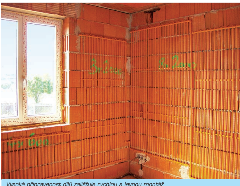
Vysoká připravenost dílů zajišťuje rychlou a levnou montáž
